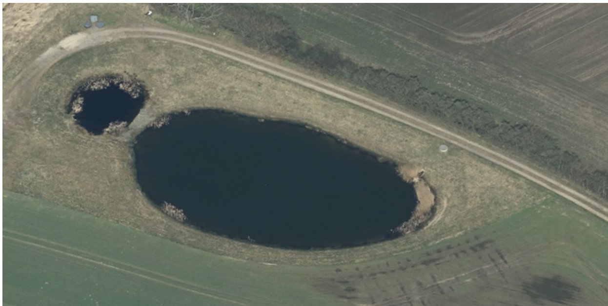
Foto 1: Vådt regnvandsbassin med forbassin til for-rensning.
