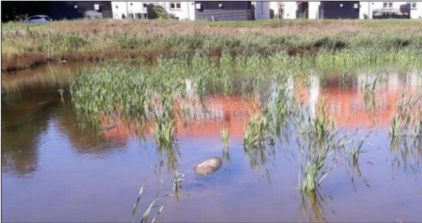
Eksempel på EPDM-membran i bassin fra Novafos (Furesø Kommune)
