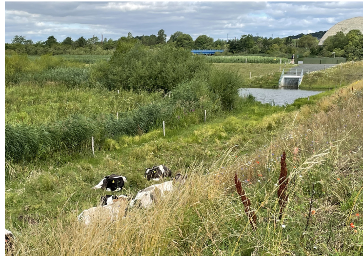
Græssende køer med ny pumpestation i baggrunden.
