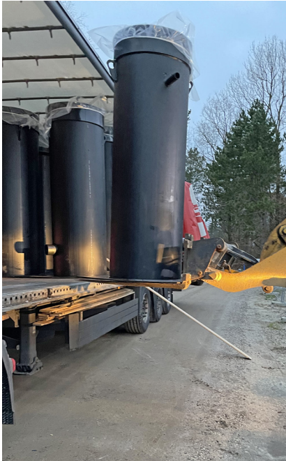
Vakuumbønde: Vakuumbønde leveres og aflæsses på pladsen.
