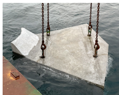
Figur 13 Nedhejsning af betonkrave.
