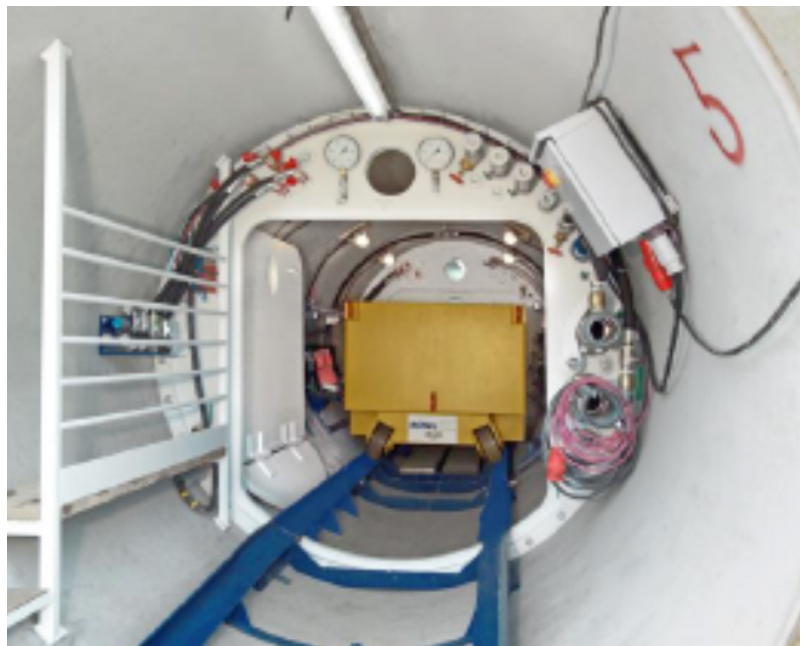
Figur 4 Trykluse i fm. tunnelering med trykluft.
