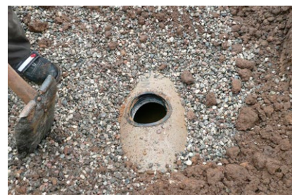
Inspektionsbrønd for test.
