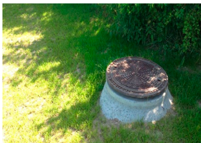
Offerledning i Hjarup.
