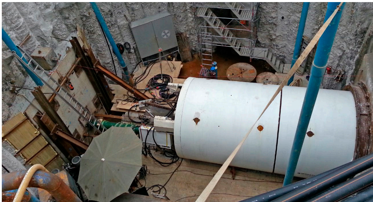
Tunnelboremaskinen installeret i byggegruben.
