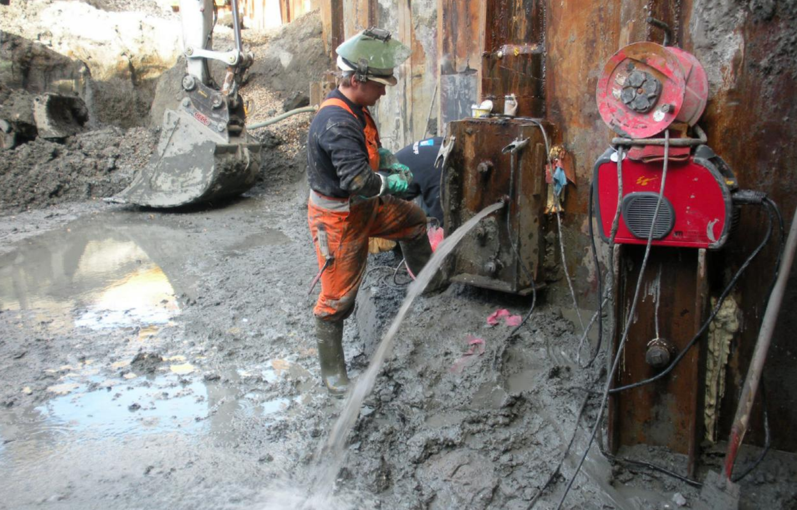
Figur 3. En af to smede i fuld gang med tætningsarbejdet.
