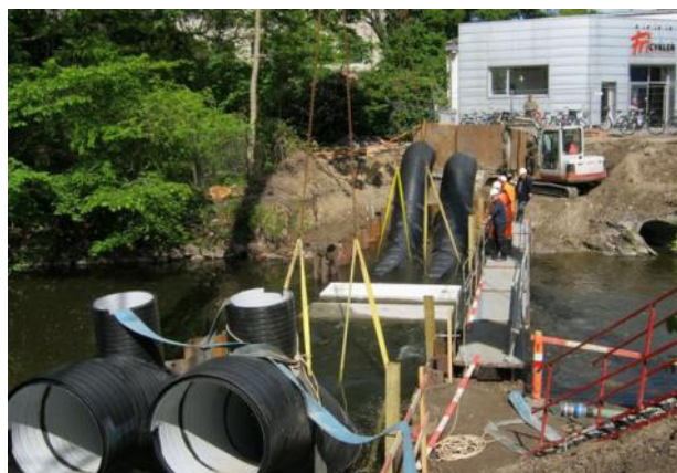
Figur 6. Tilløbsledning på tværs af Aarhus Å i spunsset udgravning.
