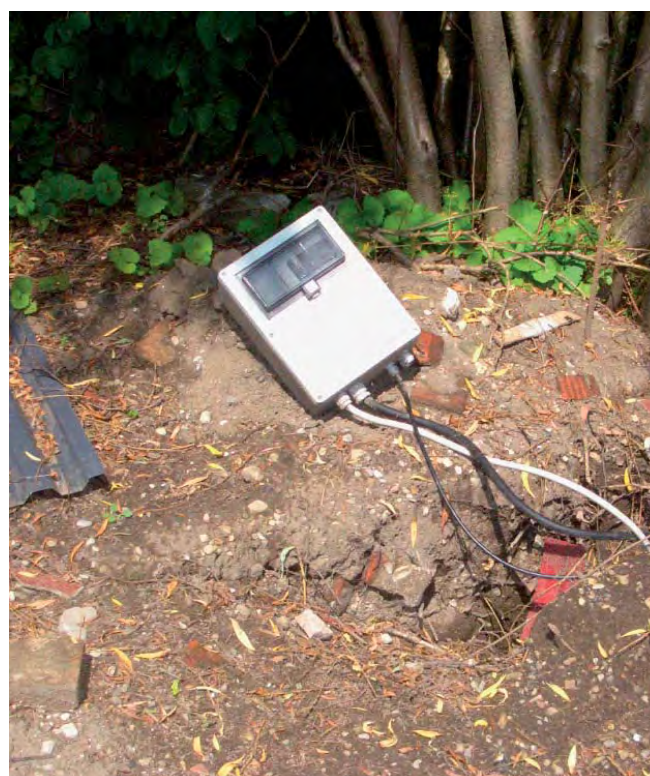
Ulovlig el-tavle til minipumpestation
