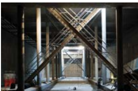
Forside foto: 8.000 m 2 bassin under Sankt Annæ Plads i København
