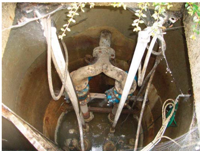
Særdeles vanskelige arbejdsforhold i en pumpebrønd.
