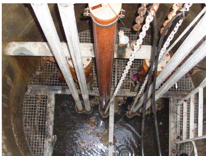
Et billede af meget snævre arbejdsforhold i en pumpebrønd.
