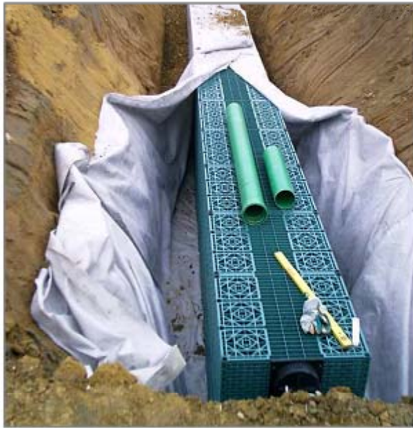
Figur 12: Rendefaskine med regnvandskassetter. Skitsen viser rendefaskine med sten.
