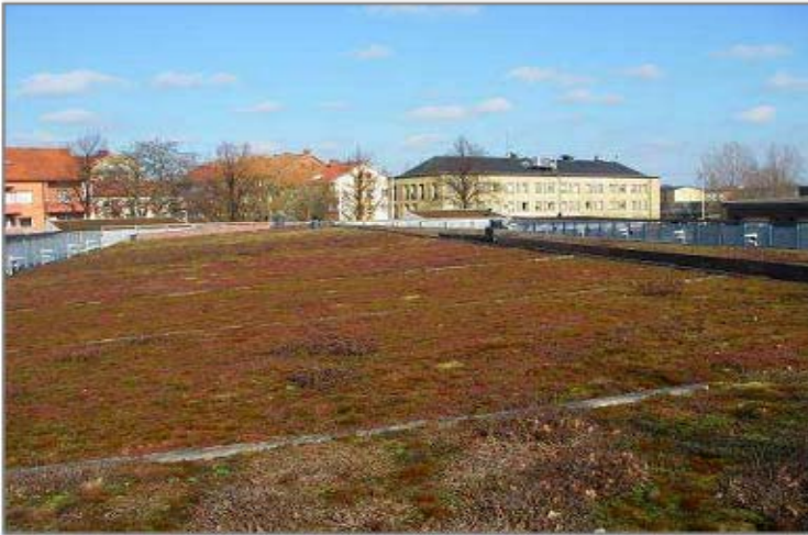
Figur 15: Sedumtaget er den mest udbredte form for ekstensive grønne tage (Foto A. Backhaus).
